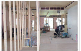
工事が進んでいます。
